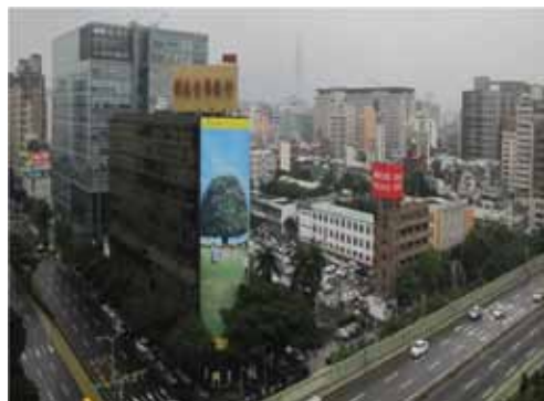
更新前為老舊辦公大樓，結構老舊、內部設施不足等問題
